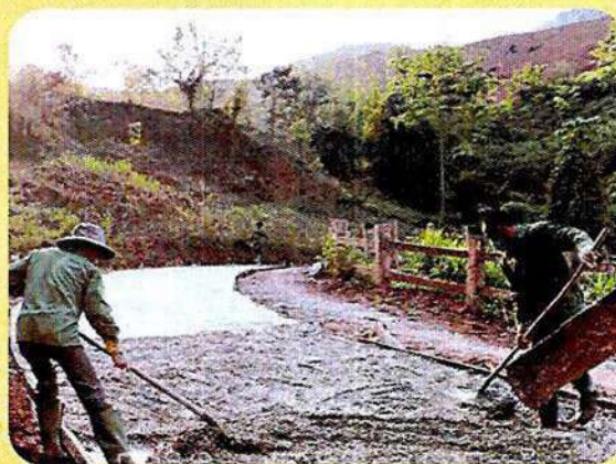
Hình 10. Nâng cấp, sửa chữa tuyến đường Nậm Pố – Nậm V (huyện Mường Nhé)
